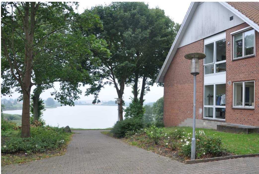
Figur 16. Sti fra handsgaden i Glumsø, der fører direkte til det grønne område omkring Glumsø sø. Belysningen stopper ved byens udkant.
