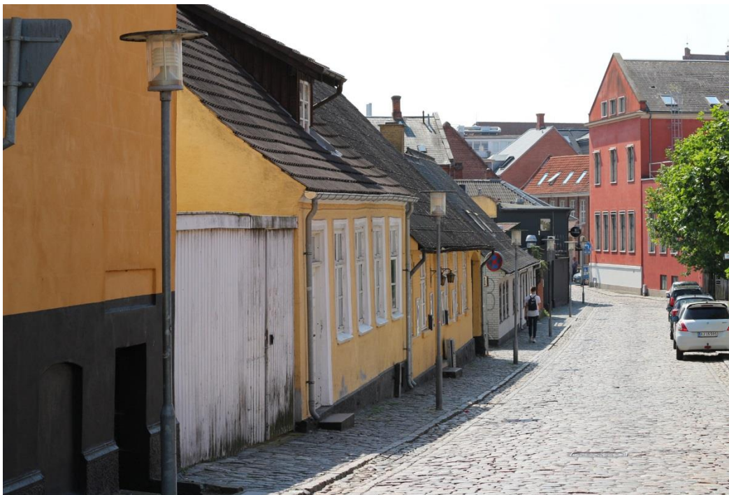
Figur 19. På Nygade i Næstveds bymidte ligger en række ældre huse, som giver gaden et idyllisk præg. Gaden er samtidig en vigtig forbindelsesvej fra de indre gågader til Grønnegades Kaserne Kulturcenter. En tilpasset gadelygte vil her være relevant.
