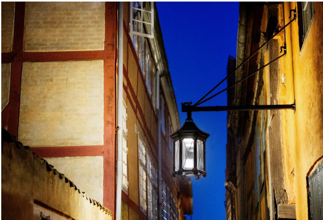
Figur 49. I Helsingør har man fået udviklet en ny LED version af den gamle bylanterne. Den nye lanterne anvendes i udvalgte gader og smøger med henblik på at understøtte den ældre arkitektur og bybilledet.
