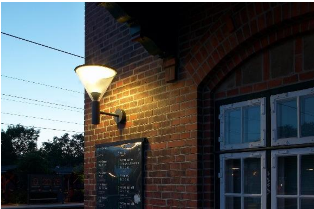
Figur 41. Parklygte monteret på væg, hvorved bygningen fremhæves. Her ses belysning på Skodsborg Station.
