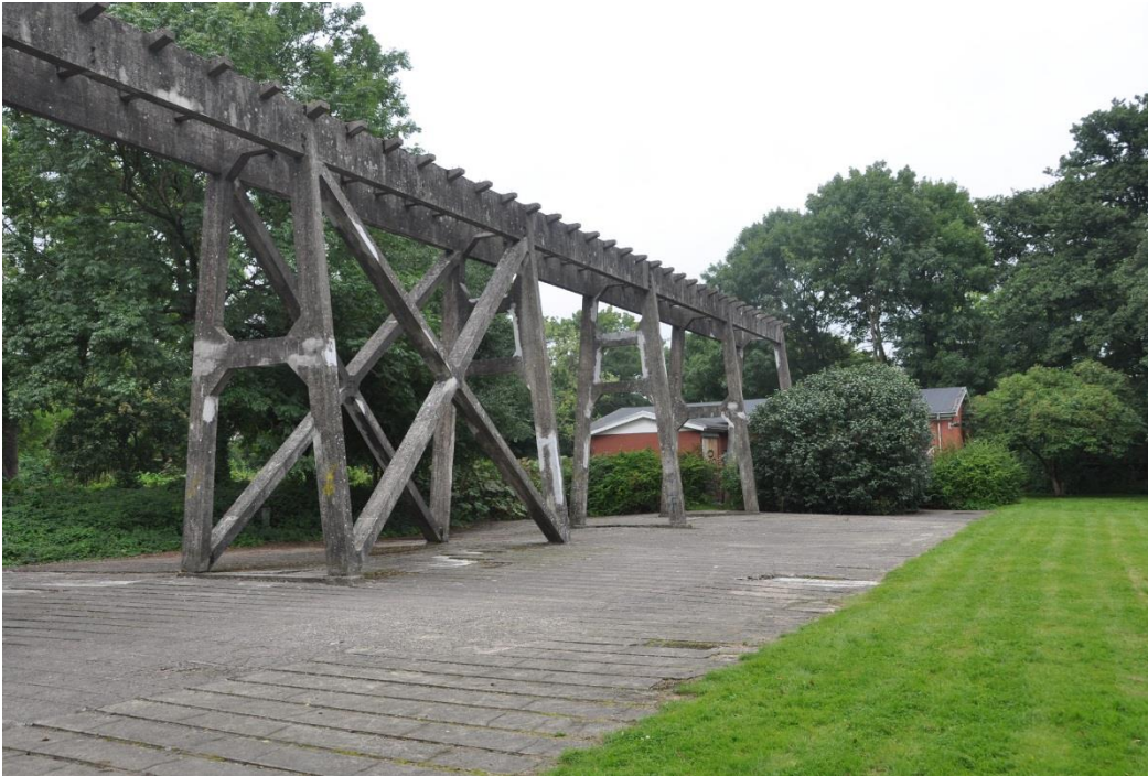
Figur 35. Kranøen ved Rådmandshaven er et levn fra den tidligere papirfabrik, der var placeret på stedet. En belysning af den gamle konstruktion kan fremhæve stedets historie, skabe stemning og lyst til ophold
